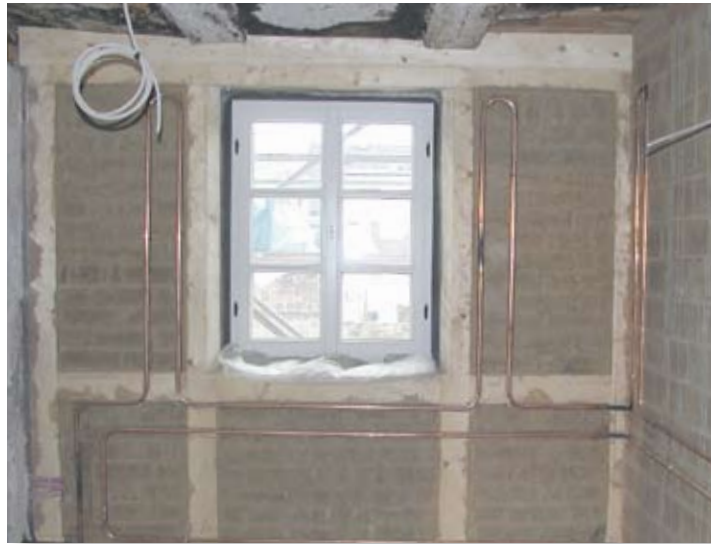
Beispiel einer Innendämmung aus Lehmziegeln mit Wandtemperierung am Lochnerschen Gartenhaus
