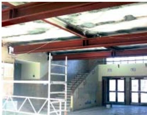
Links: Sanierung der ehemaligen Highschool: Um die Tragfähigkeit der Decken zu gewährleisten, müssen Stahlträger eingezogen werden.
