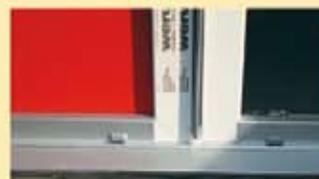
Detailpunkt Schwelle mit Sattelschiene und zusätzlichem Statikprofil
