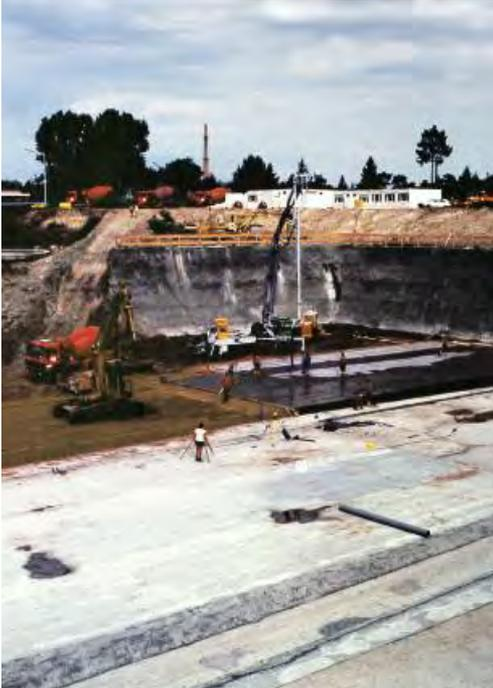
**Aufgrund erneut strengerer gesetzlicher Auflagen musste die Biologische Reinigungsstufe erweitert werden. Es wurden zusätzliche Becken mit einem Volumen von 24.000 m<sup>3</sup> gebaut. Im Bild zu sehen ist die Herstellung der Bodenplatte.**
