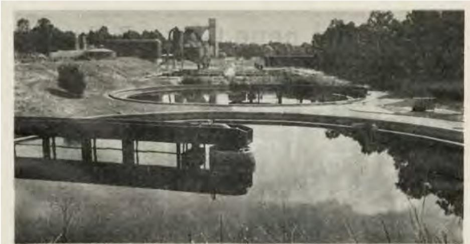
Ihren Probestoff bestanden die erweiterte biologische Stufe der Fürthener Kläranlage. Im Vordergrund sind beinahe 42 Meter im Durchmesser messenden Nachklärbecken. Deutlich erkennt man die Belüftungs-
