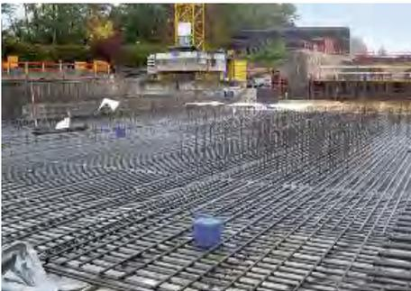
**Die Bilder zeigen die Baumaßnahme „Neubau der Mechanischen Reinigungsstufe“. Das sehr beengte Baufeld und die geologische Baugrundsituation stellen enorm hohe Anforderungen an den notwendigen Verbau. Im Bild zu sehen ist auch die sehr aufwendige Bewehrung.**
