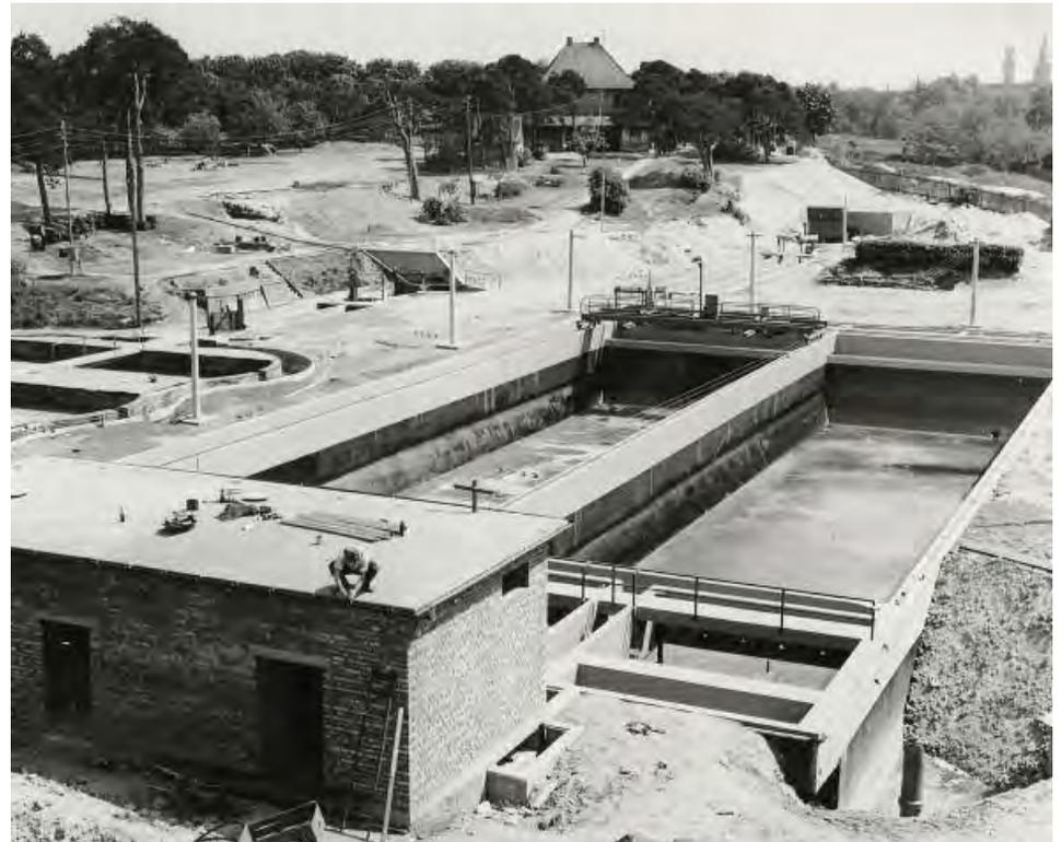
Die Bilder oben zeigen den Bau der beiden Vorklärbecken in den 1950er Jahren, die zwischen den Emscherbrunnen (links im Bild) und dem Regnitzufer angeordnet wurden. Im Hintergrund steht das Klärwärterwohnhaus.
