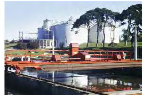
**Im Bild oben sind die beiden Faulbehälter dargestellt, die 1953 errichtet wurden. Davor angeordnet sind die beiden Aero-Acceleratoren. Im Bild darunter sieht man die Vorklärbecken, im Hintergrund wiederum die beiden Faulbehälter.**
