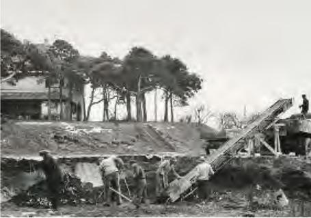
**Der Aushub für den Zuleitungskanal und für die Rechen- und Sandfanganlage unterhalb des Klärwärterwohnhauses erfolgte ohne technische Hilfsmittel. Lediglich ein Förderband zur Beladung der Lastwagen stand zur Verfügung.**
