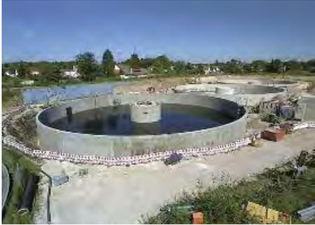
Nach der Betonage der drei Nachklärbecken muss die Dichtigkeit der Becken durch Wasserfüllung überprüft werden. Erst dann können die Verfüllarbeiten ausgeführt werden.
