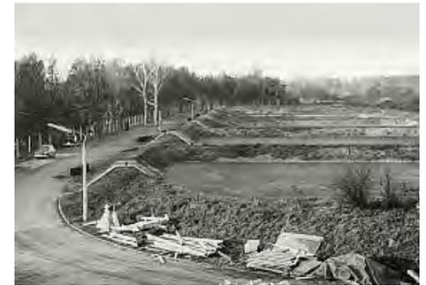
**Anstelle der alten Schlammstapelbecken wurde 1972 eine zweite Biologische Reinigungsstufe mit Nachklärbecken und Schneckenhebewerk errichtet.**
