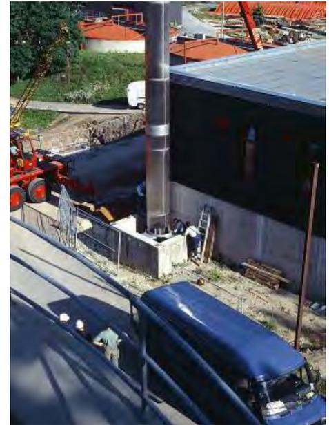
**Abgaskamin der BHKWs: Die Abhitze der Abgase wird in Wärmetauschern zurückgewonnen. Die Wärmeenergie wird zur Beheizung der Faulbehälter und der Betriebsgebäude genutzt.**
