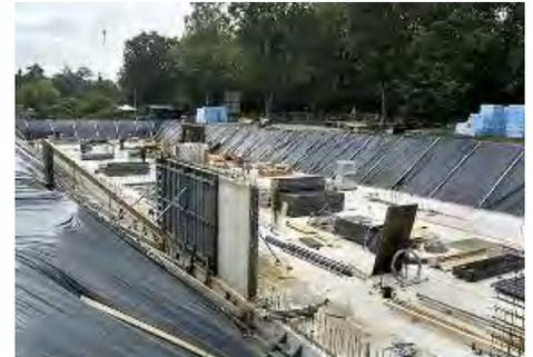
Oben sind die Baugrube und die bereits betonierte Bodenplatte des neuen Betriebsgebäudes zu sehen. Das Bild links zeigt das Aufbringen eines Nachklärbeckenräumers auf ein bereits betoniertes Becken.
