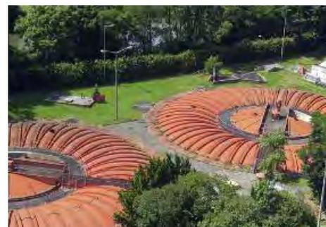
Die rot abgedeckten Becken im Bild unten sind die in den Jahren 1959 bis 1961 errichteten Aero-Acceleratoren – die erste Biologische Reinigungsanlage. Das Bild oben zeigt die viel größere, im Jahr 1994 in Betrieb genommene biologische Reinigung.
