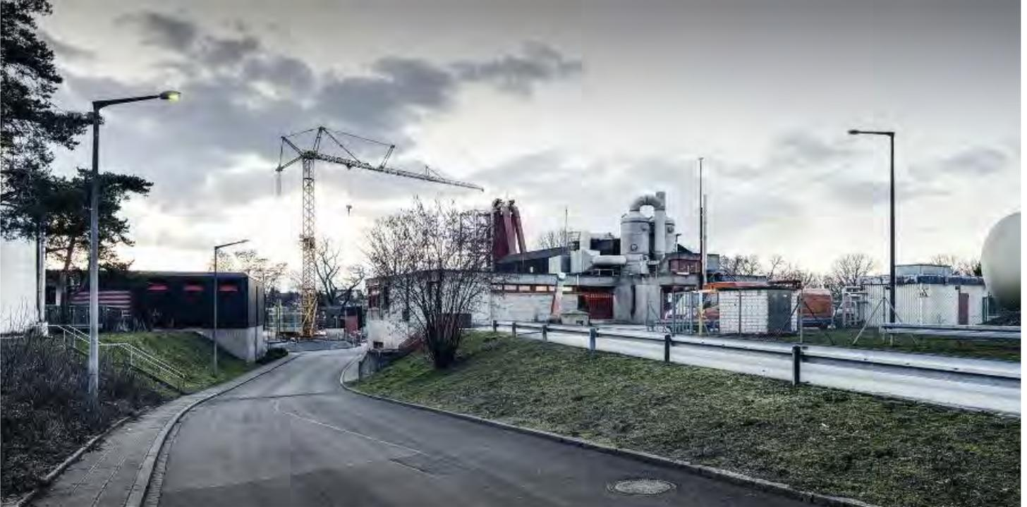
**Im Jahr 1978 erfolgte die Inbetriebnahme der Schlammwässerungsanlage. Damals wurde der Klärschlamm thermisch konditioniert, d. h. gekocht, um ihn besser entwässern zu können. Nach Umstellung auf Polymerkonditionierung, konnte man das Klärgas 1994 zur Erzeugung von Strom und Wärme in Blockheizkraftwerken einsetzen.**
