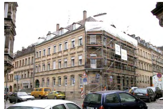
Sanierungsergänzungsprogramm: Fassadenreinigung und -sanierung (rechte Fassadenhälfte noch unsaniert)
