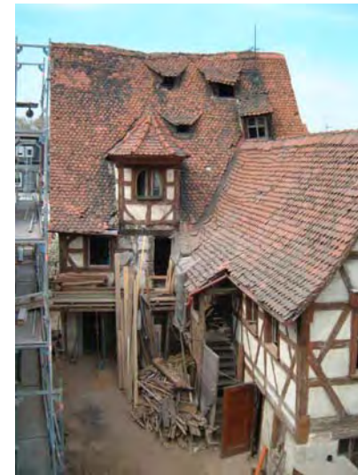
Objekt sanierung am Beispiel "Stadlerhof" am Grünen Markt (erste Erwähnung um 1500)
