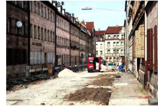
Pfisterstraße während der Umbauphase
