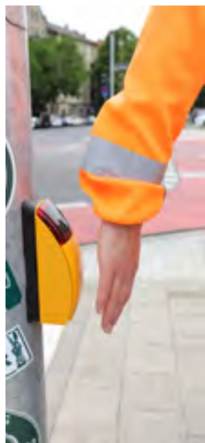
Der Radartaster funktioniert kontaktlos.
