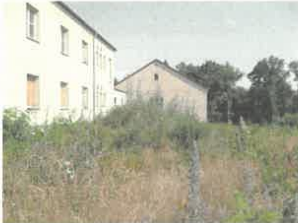
Ansicht Ostseite mit Verbindungs- gang/Geb. 309
