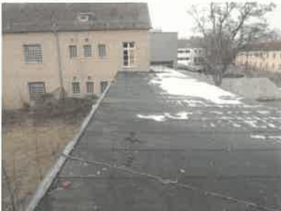
Blick auf Dach nach Westen (Gebäude 311)
