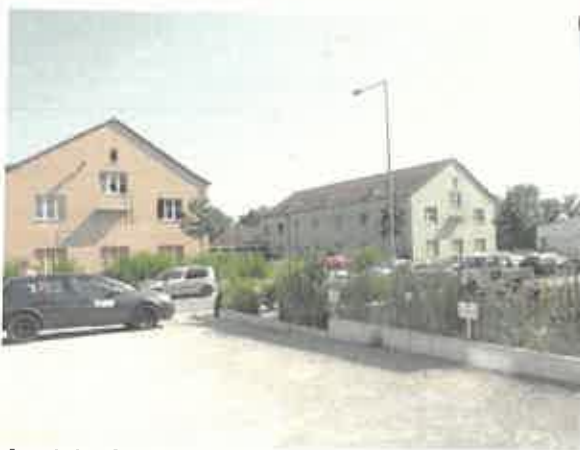
Ansicht Südseite (linkes Gebäude)
