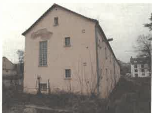
Ansicht Ost- und Nordseite Ostteil
