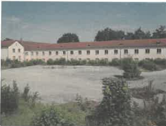
Ansicht Südseite Ostteil
