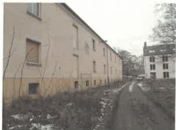
Ansicht Nordseite Ostteil
